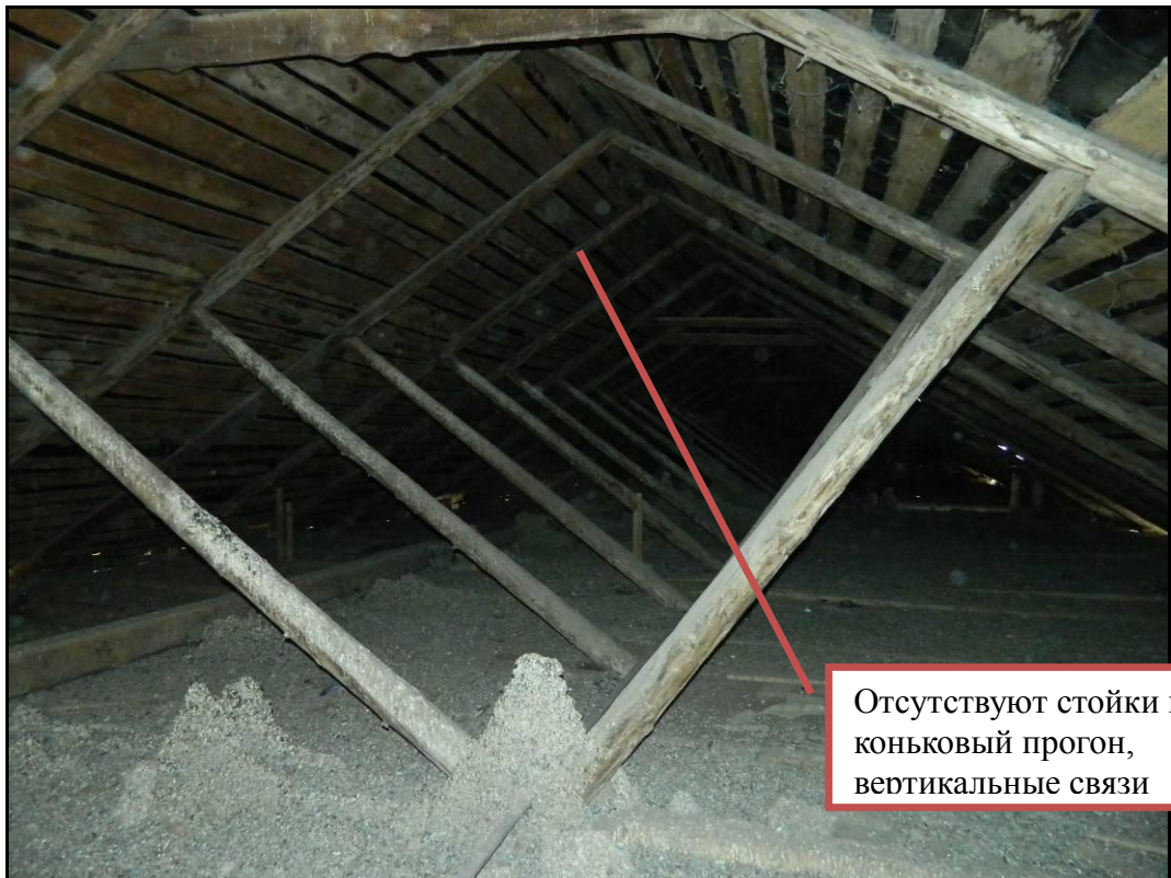
Рис.18 Фрагмент стропильной системы в осях «1-13»
