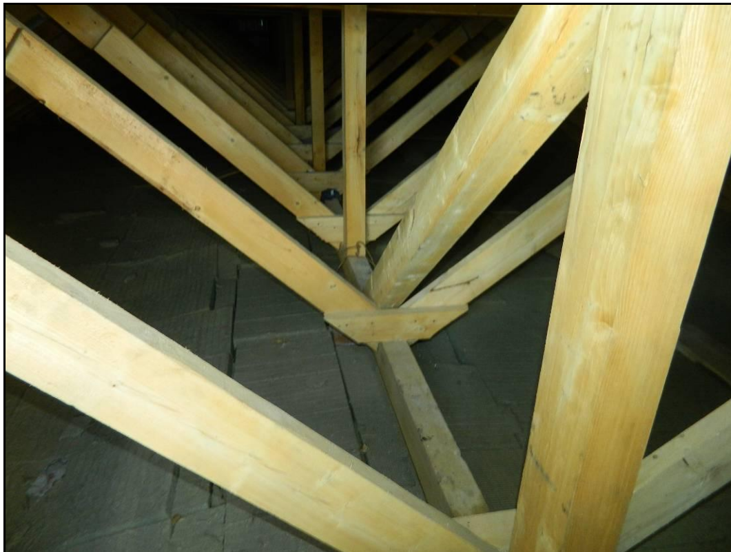
Рис.23 Фрагмент стропильной системы в осях «14-15/Т-Ж»
