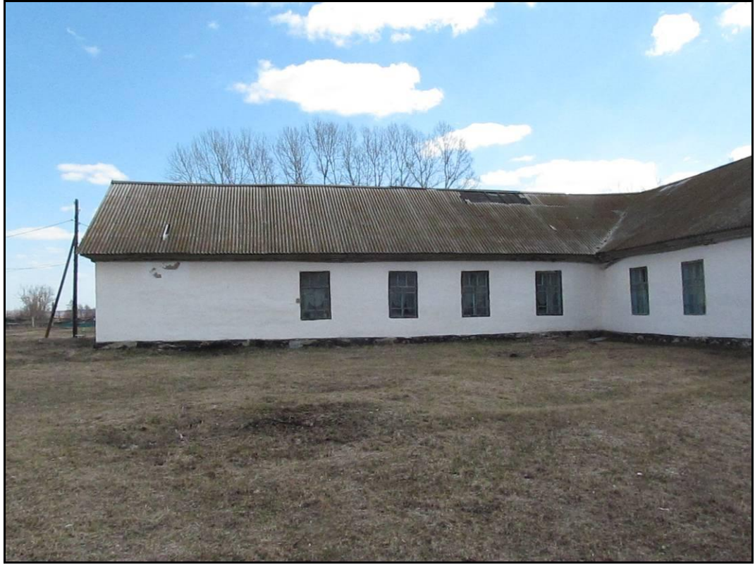
Фрагмент фасада в осях «4/Д-Р»
