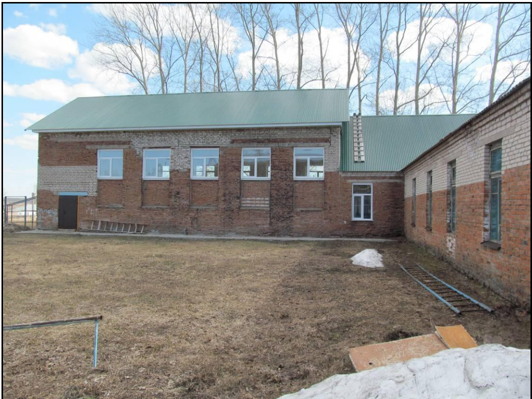
Рис.6 Фрагмент фасада в осях «14/Т-Ж».
