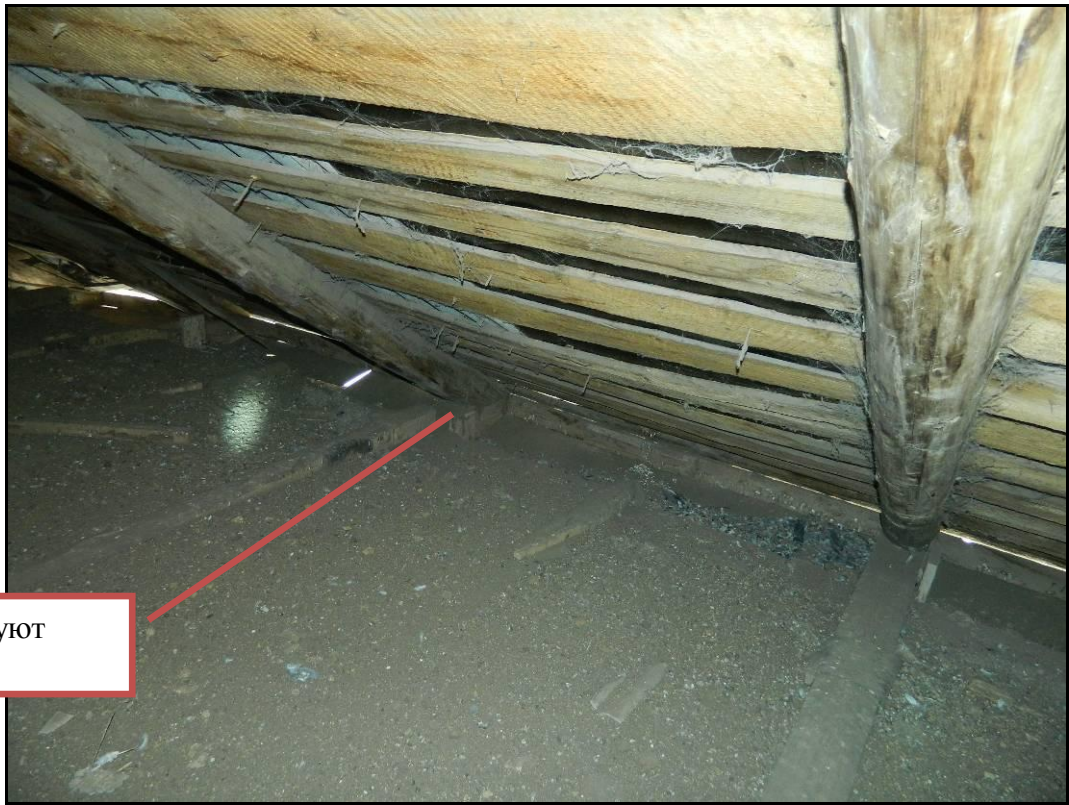
Рис.13 Узел опирания стропильных ног в осях «1-13»
