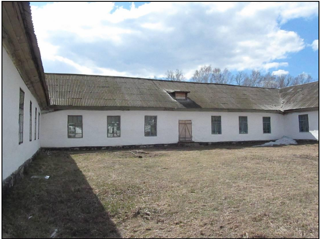
Фрагмент фасада в осях «10-4/Д»
