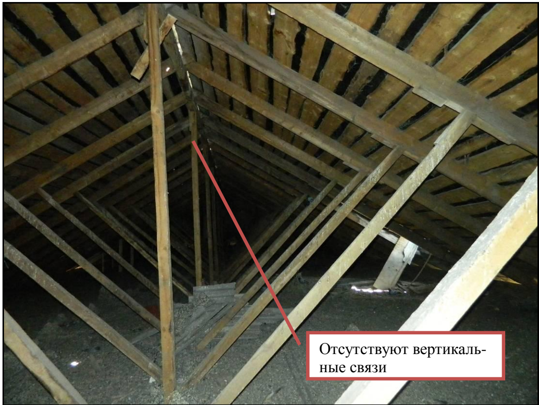
Рис.19 Фрагмент стропильной системы в осях «13-15»
