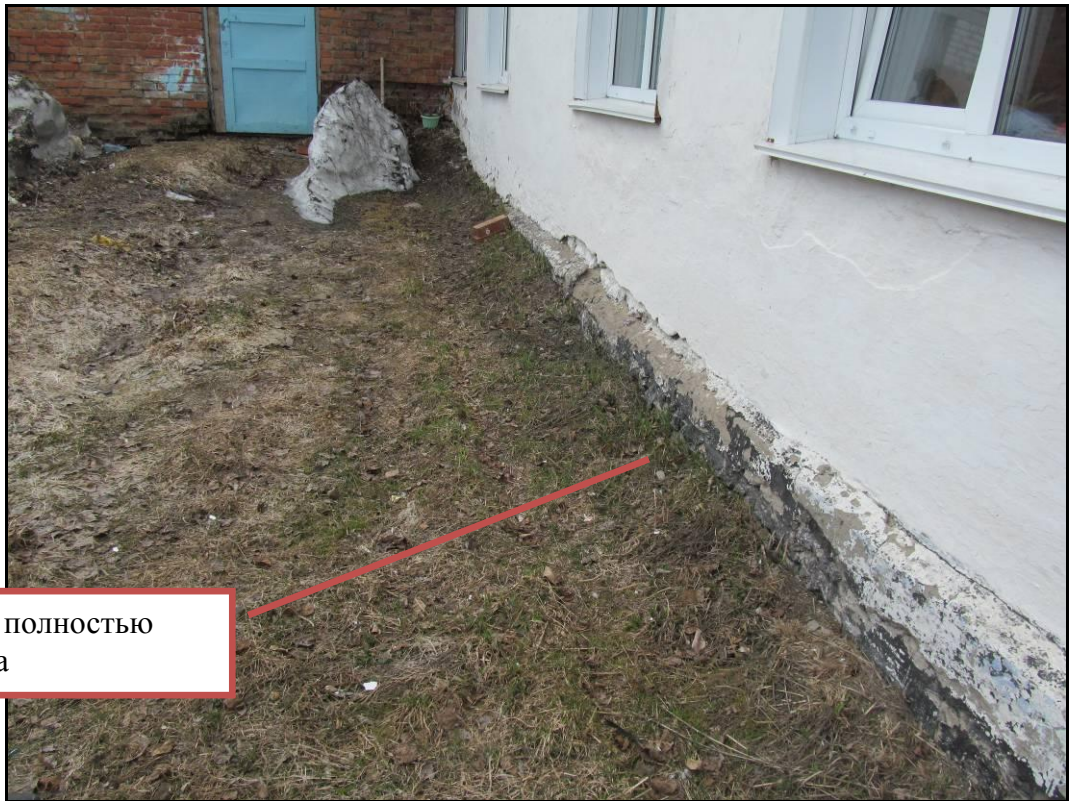
Рис. 3 Фрагмент отмостки здания
