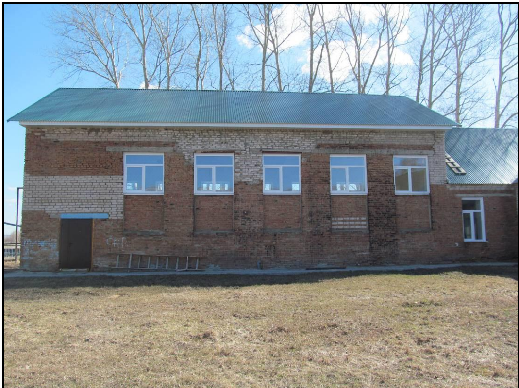
Рис.12 Фрагмент фасада в осях «14/Г-Ж»
