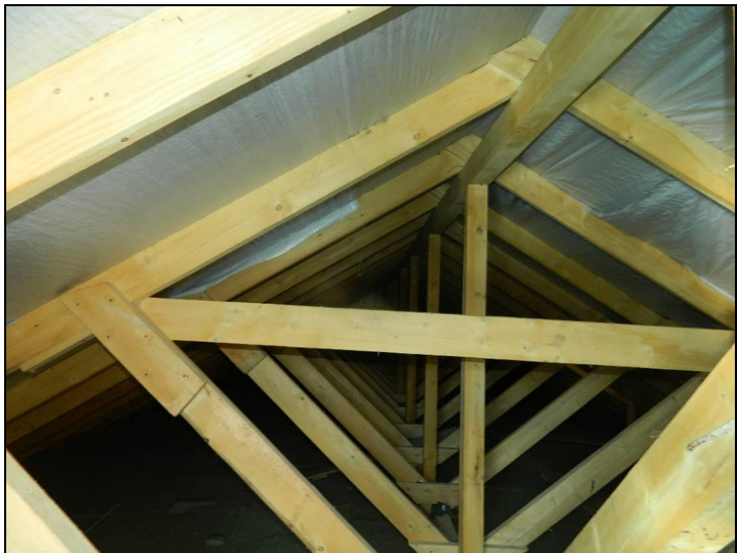
Рис.22 Фрагмент стропильной системы в осях «14-15/Т-Ж»
