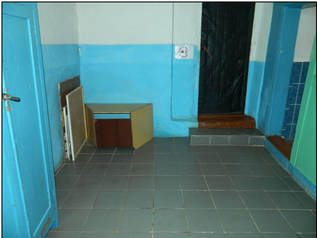
Рис.28 Фрагмент пола с покрытием из керамической плитки
