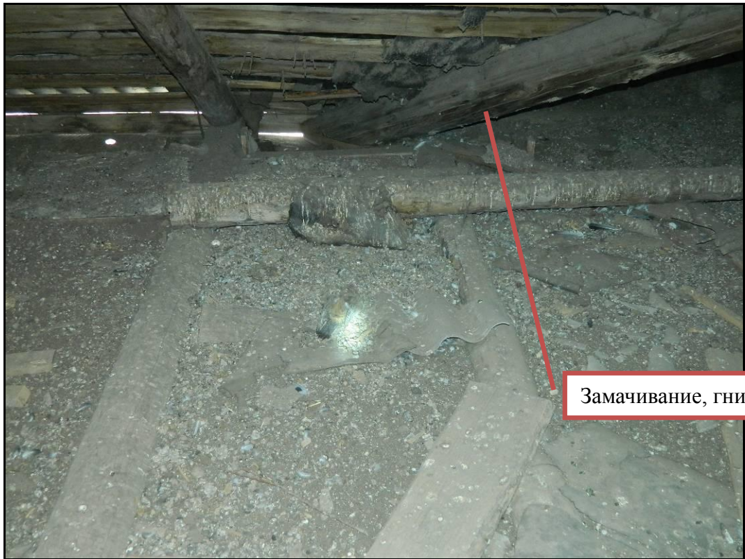
Рис.27 Фрагмент чердачного помещения в осях «1-14»
