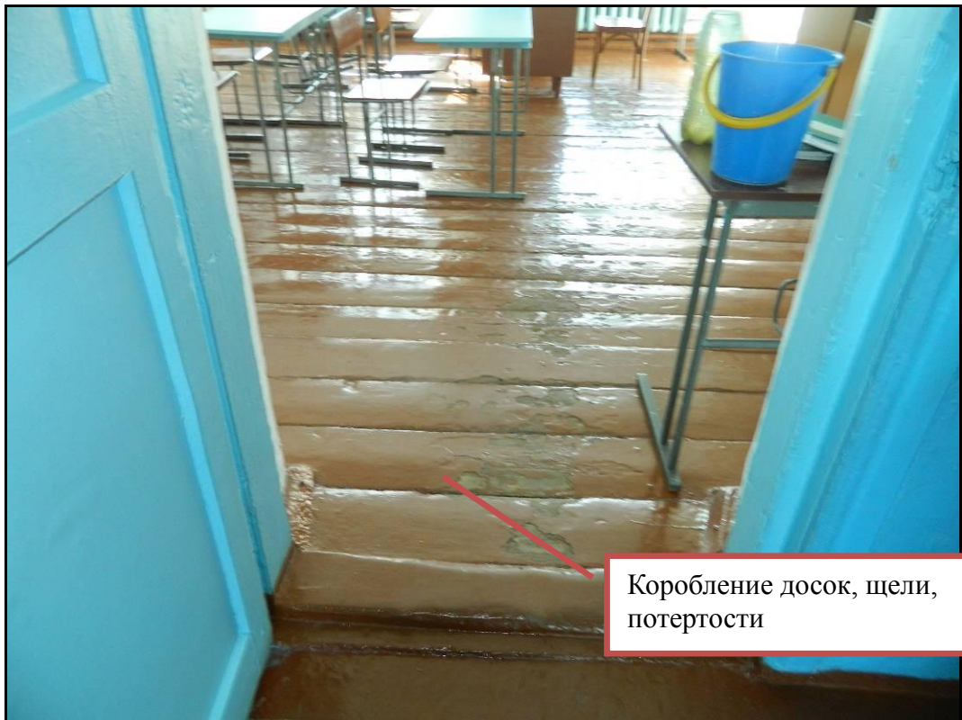
Рис.26 Фрагмент дощатого пола.
