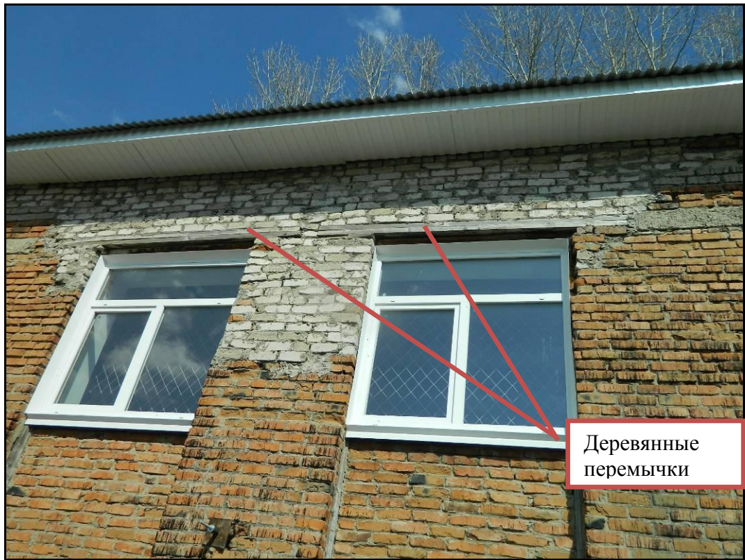
Рис.7 Фрагмент фасада в осях «14/Т-Ж»
